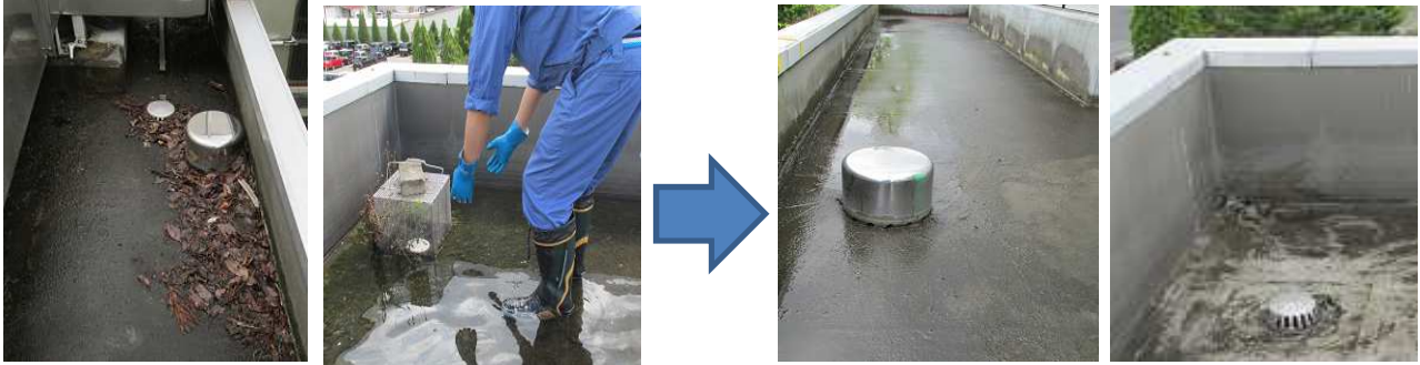
工場屋上の排水口回りの定期的な清掃実施
